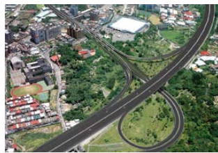
新北市特二號道路銜接土城交流道
