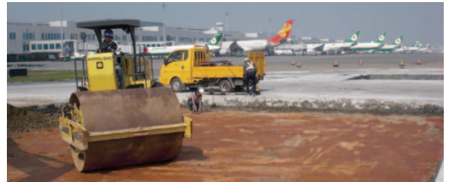
臺灣桃園國際機場道面整建
