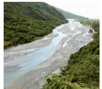
花蓮西寶水力發電計畫
