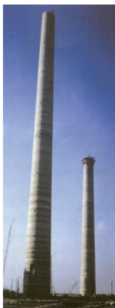
臺中火力發電廠
