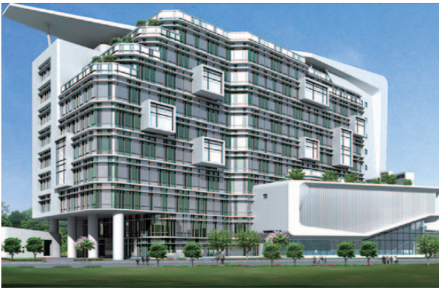
新北市立圖書館新建工程
