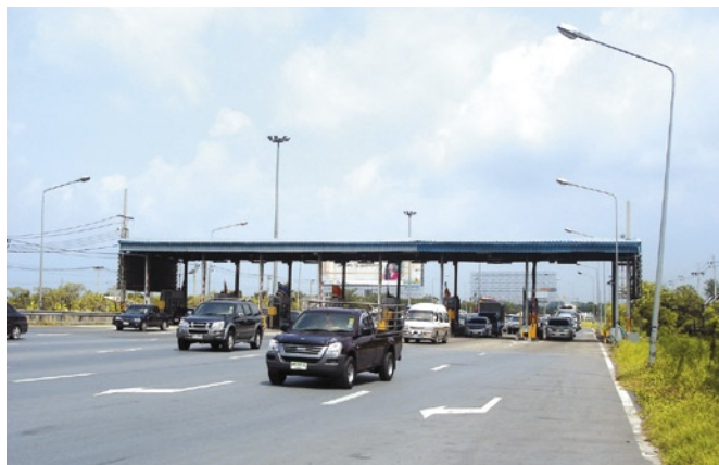
ETA Toll Plaza, Thailand
