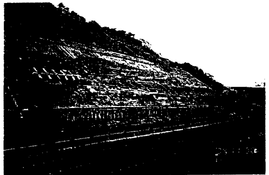
照片二 案例一整治完工後情形(拍攝角度與照片一相同)
