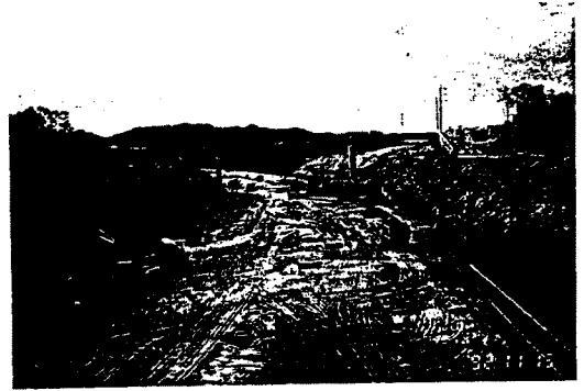
照片三 案例二坍塌整治施工情形(擋土樁已打設，黑色部份為地下水滲水位置)
