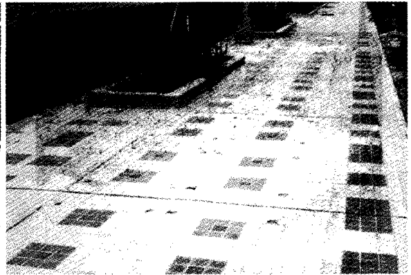
圖 25 電纜溝埋設與接戶示意圖 圖 26 人行道下佈設電纜溝完工實例
