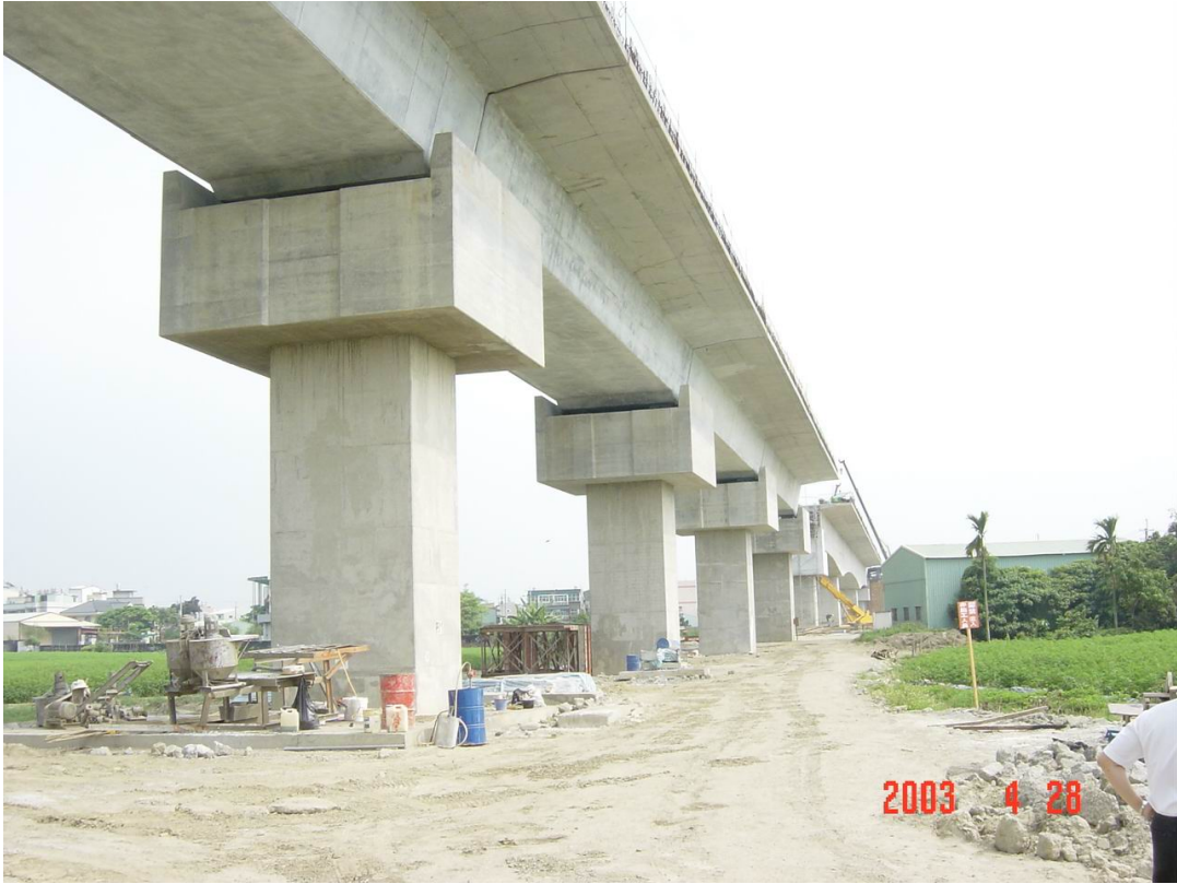
圖 5.4 橫向鋼筋混凝土止震塊
